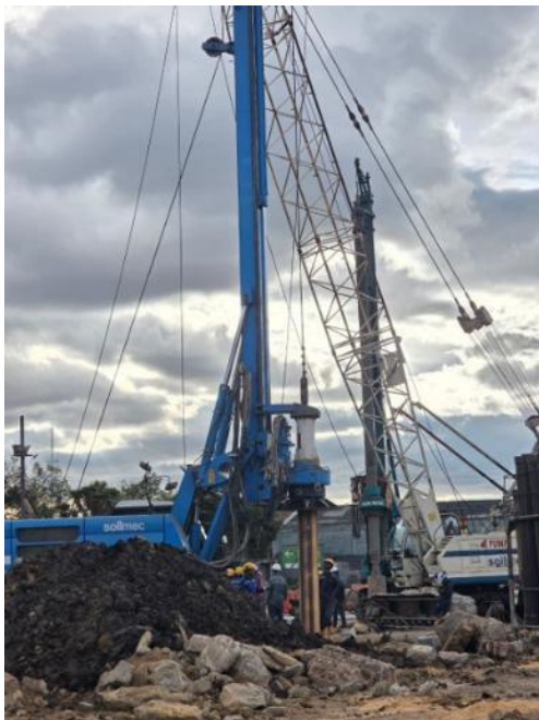
Ilustración 4. Proceso de Pilotaje
