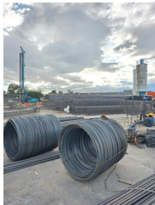
Ilustración 5. Canastas para pilotes
