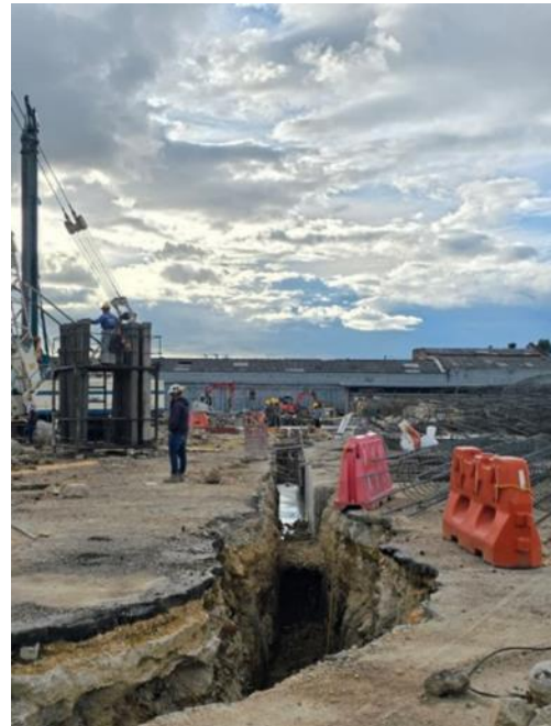
Ilustración 3. Excavación para realización de viga guía en el perímetro del sótano.
