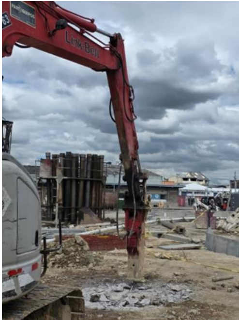
Ilustración 2. Demolición de placas de concreto
