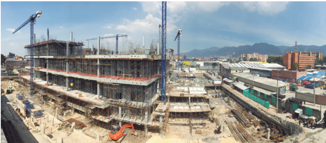
ÁGORA BOGOTÁ–Vista del proceso de construcción desde el edificio de parqueaderos al costado sur
