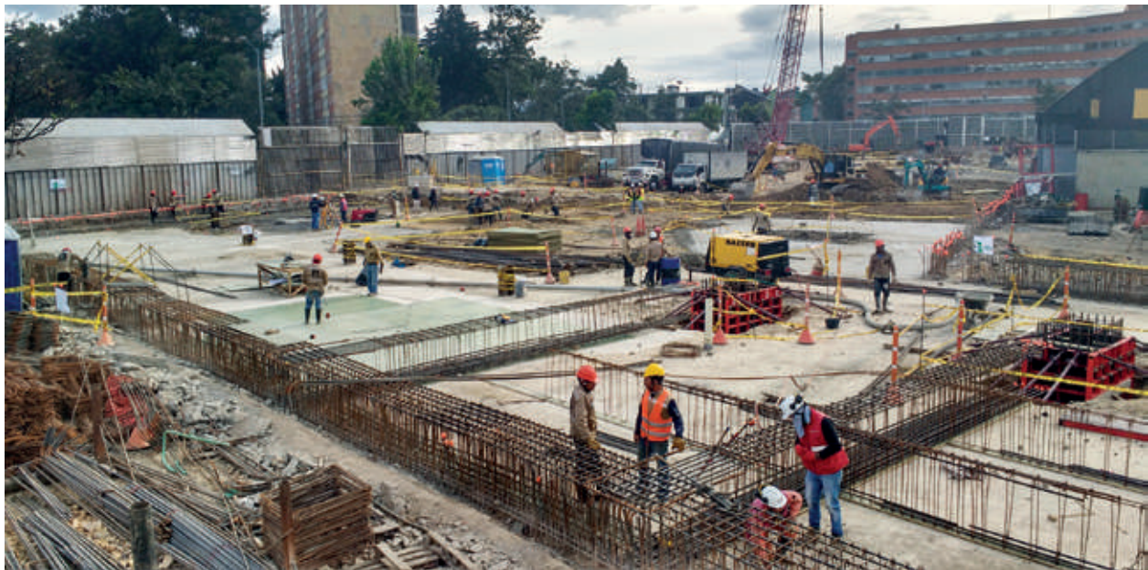
HOTEL – Avance de la obra.
