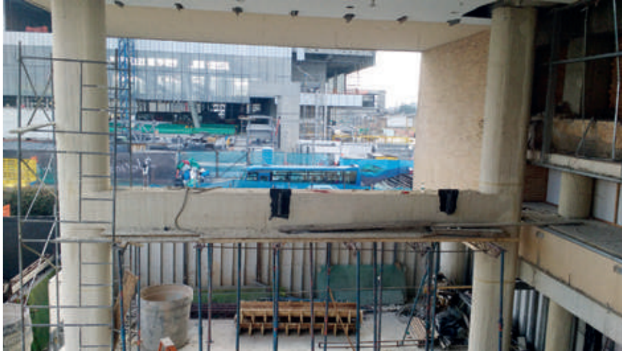
ENLACE PEATONAL ENTRE PREDIOS 1 Y 2 – Avance de la obra.
