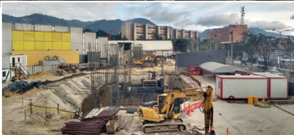
BORDE ACTIVO – Avance de la obra.
