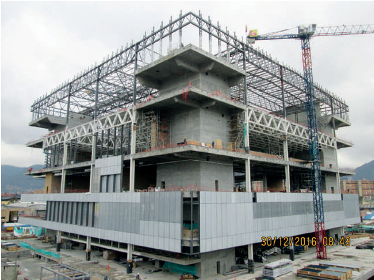
ÁGORA BOGOTÁ – Vista del avance de la obra desde la Avenida la Esperanza hacia el occidente.
