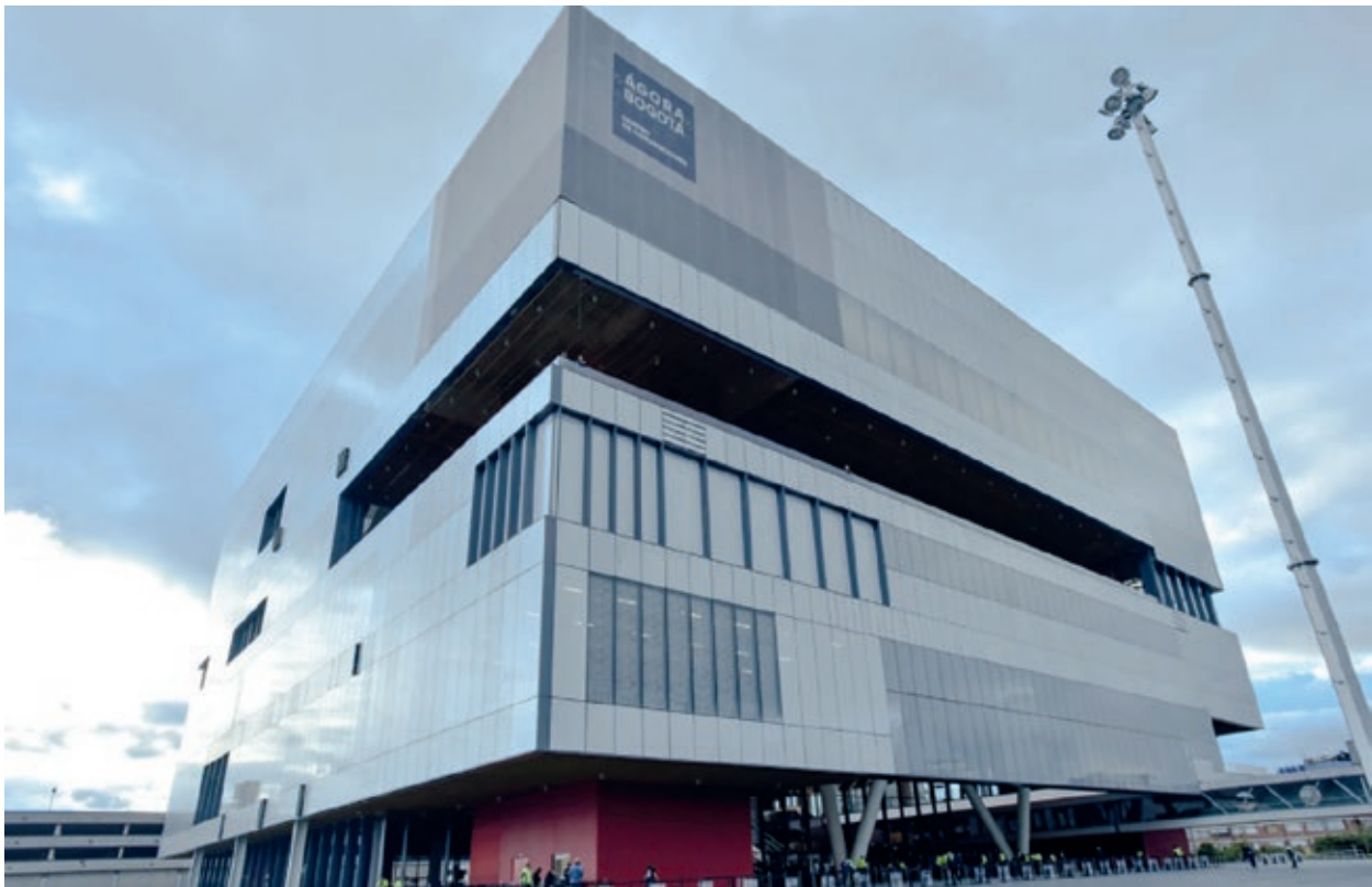
ÁGORA BOGOTÁ – Vista de la obra desde la Avenida la Esperanza hacia el occidente
