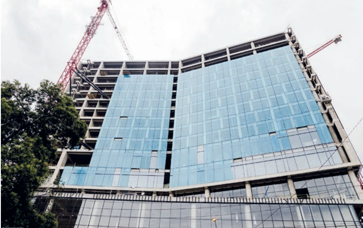
Vista Fachada sobre Cra. 37: Plataforma (4 primeros niveles y Torre Pisos 5 al 17)
