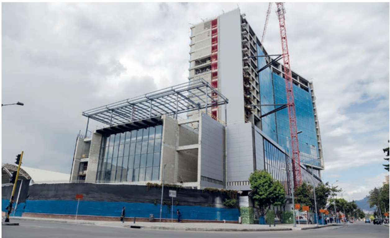
Vista Esquina Cra. 37 con Avda. Esperanza. En la esquina se aprecia el volumen del "Ball Room"
