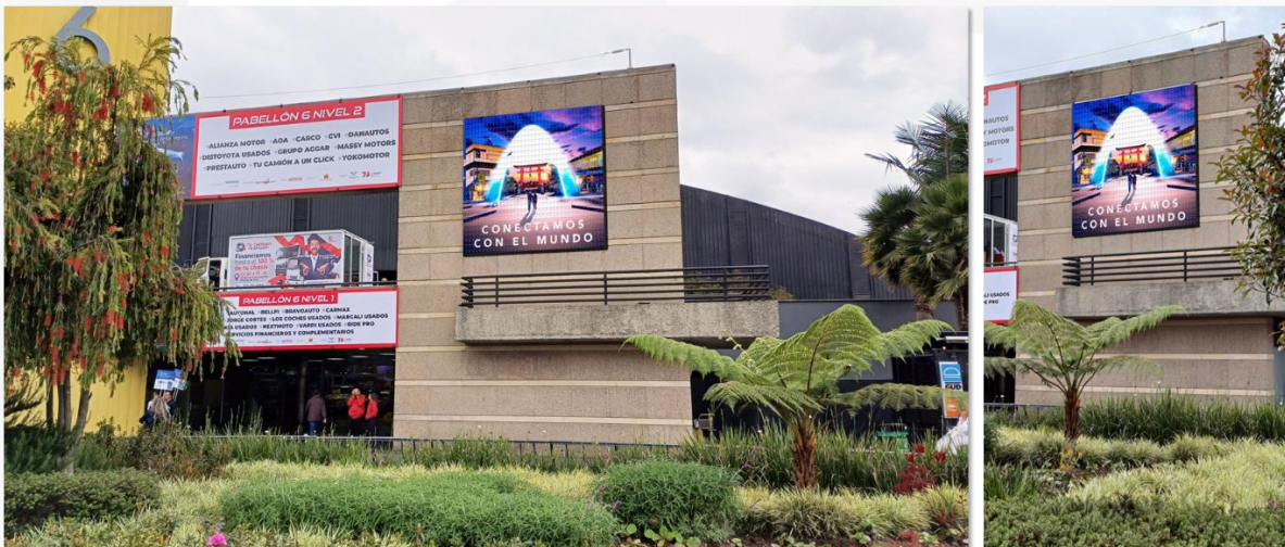
Ilustración 7: Fachada del Pabellón 6 - Referencia visual de la Señalización
