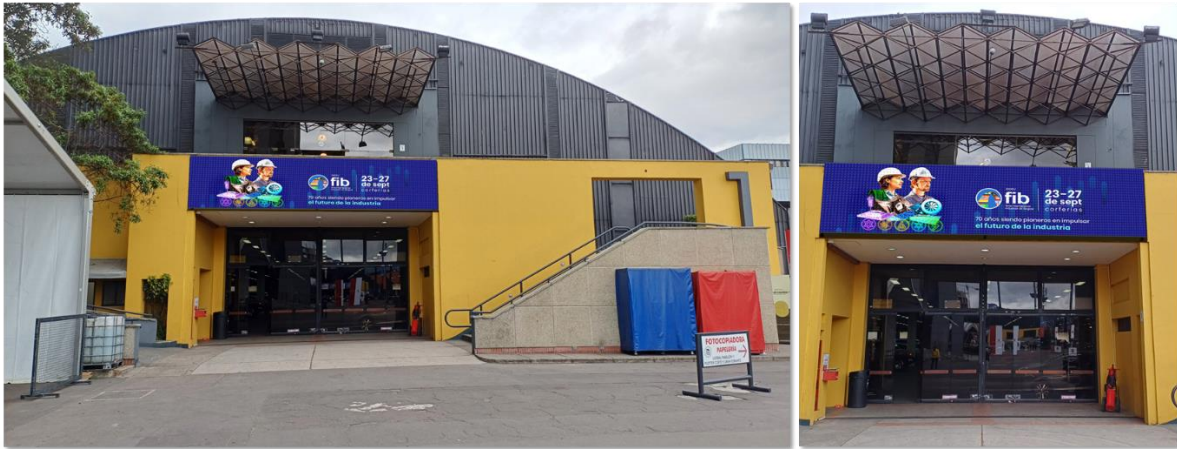
Ilustración 4: Fachada del Pabellón 1 - Referencia visual de la Señalización
