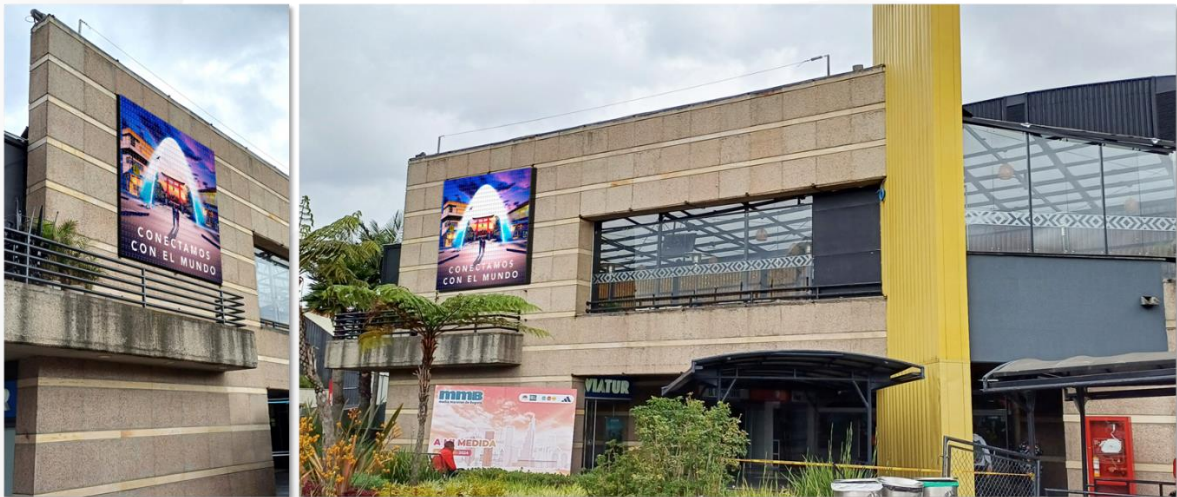
Ilustración 3: Fachada del Pabellón 3 - Referencia visual de la Señalización
