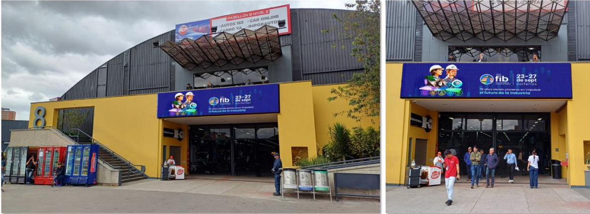
Ilustración 8: Fachada del Pabellón 8 - Referencia visual de la Señalización
