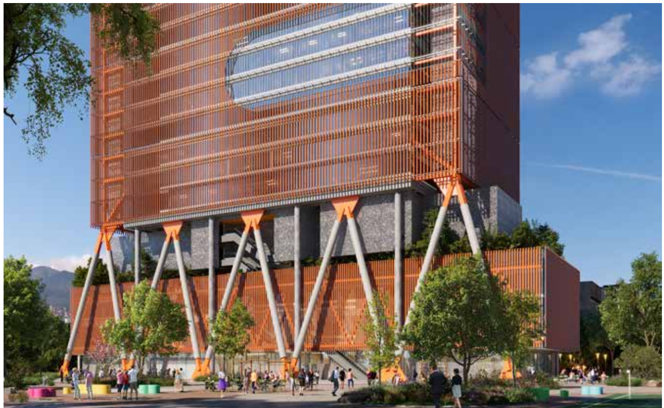
Vista del proyecto desde Av. Ferrocarril de Occidente. Fuente: elaboración Consorcio Mazzanti + Gensler
